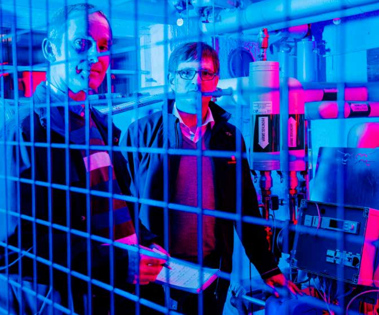
アパートの地下にて、アルファ・ラバルのマッツ・パーソン(左)とRonnebyhus社のオペレーションチーフ、クリスティアン・オルセ氏。省エネ総量はほぼ50%に達しています。
